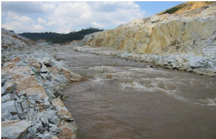
Sg. Rawang Diversion LSSC Project
