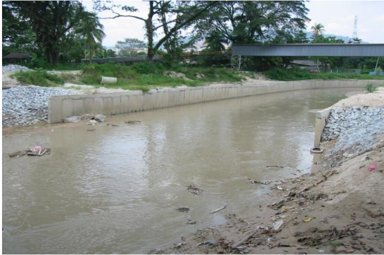
Sg. Rawang Diversion Lafarge Project Ch 3500
