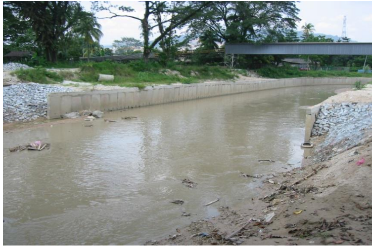
Sg. Rawang Diversion Lafarge Project Ch 3500
