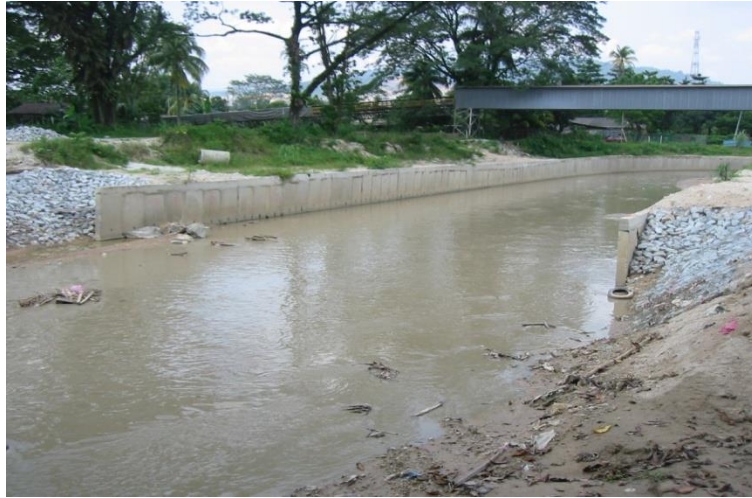
Sg. Rawang Diversion Lafarge Project Ch 3500
