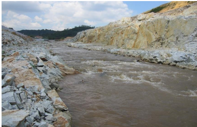
Sg. Rawang Diversion LSSC Project
